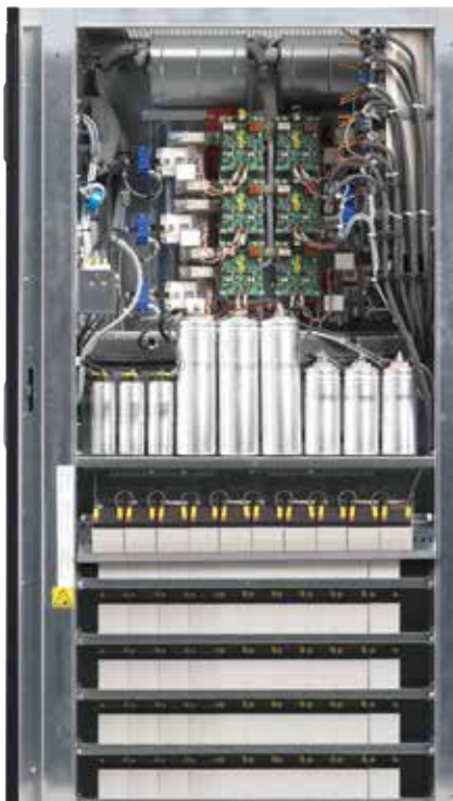
INTERNAL BATTERIE FIXTURES
